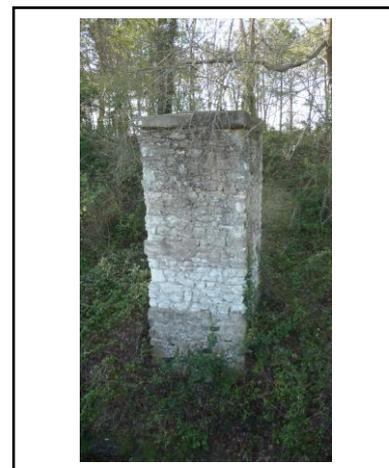
Je n'avais aucune idée sur le rôle ou l'utilité de ces constructions jusqu'à ce que la rencontre avec un ancien ouvrier du SLI permette d'établir avec certitude qu'elles n'étaient pas des « tours » accessibles du bas vers le haut mais des « regards » utilisés du haut vers le bas et permettant d'accéder à un réseau busé.
