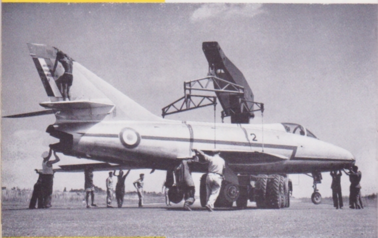
Hissage d'un avion avec une puissante grue de levage en expérimentation surnommée « ramasse-miettes ».
